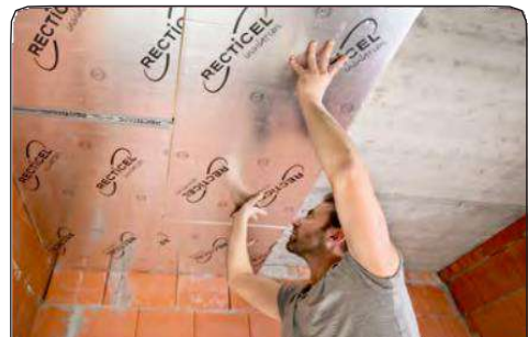
Izolarea plafonului subsolului
