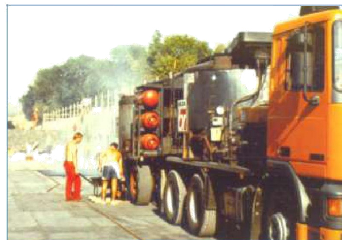
Manevrarea camionului direct pe DERBIGUM GC pentru turnarea betonului rutier
